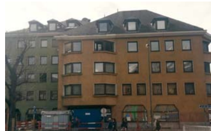
Raika, Markthalle, Innsbruck
