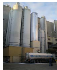
Firma Henkel, Wien, Fritz Henkelstrasse
