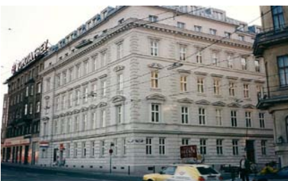
Bürogebäude, Wien, Weyringergasse
