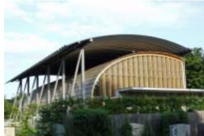
Aussegnungshalle Gräfelfing bei München
